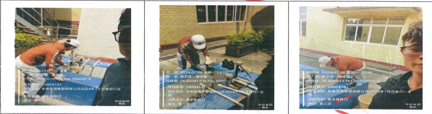
FS1：废水排放口（DW001）
